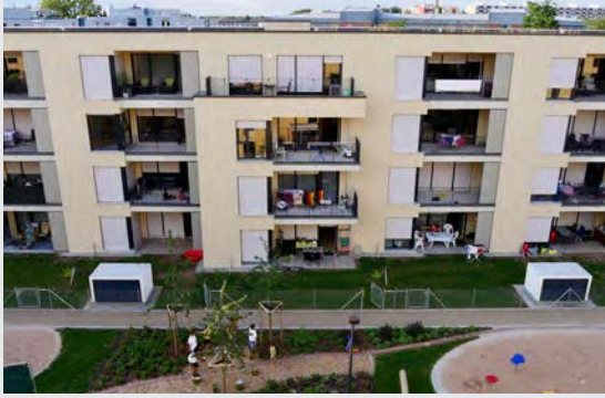
Am Nordostbahnhof 20 und 22 hat die städtische Wohnungsbaugesellschaft wbg Nürnberg 40 geförderte Wohneinheiten gebaut.
