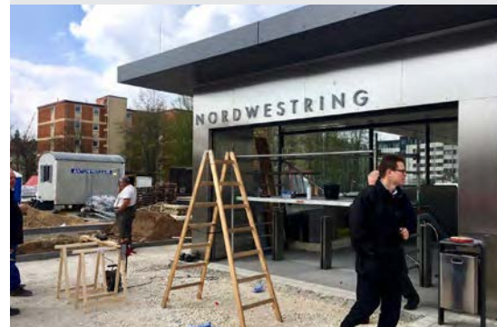
Seit Ende Mai fährt die U3 bis zum Nordwestring – das Foto zeigt den U-Bahnhof-Zugang kurz vor Fertigstellung.
